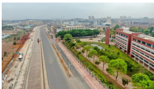
△ 博东大道杨侨段改造项目复工后加紧推进。
